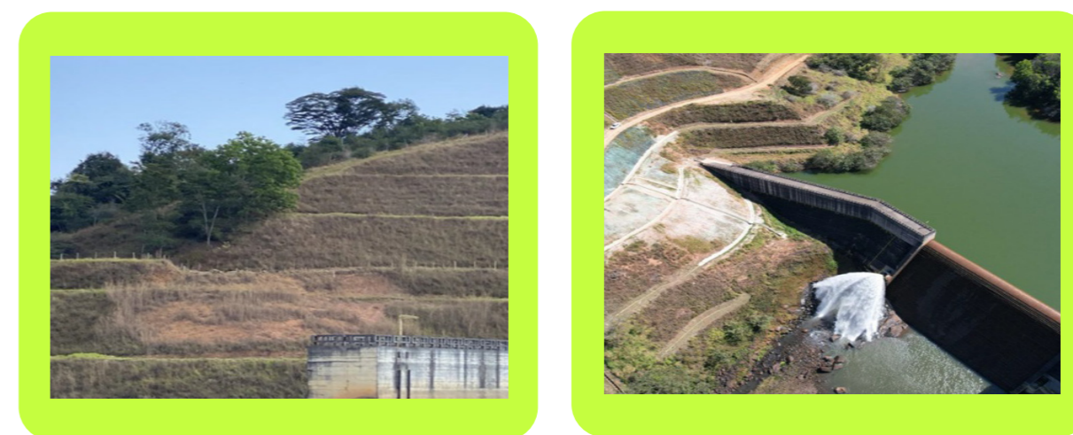
Ombreira Direita – UHE Rosal.
