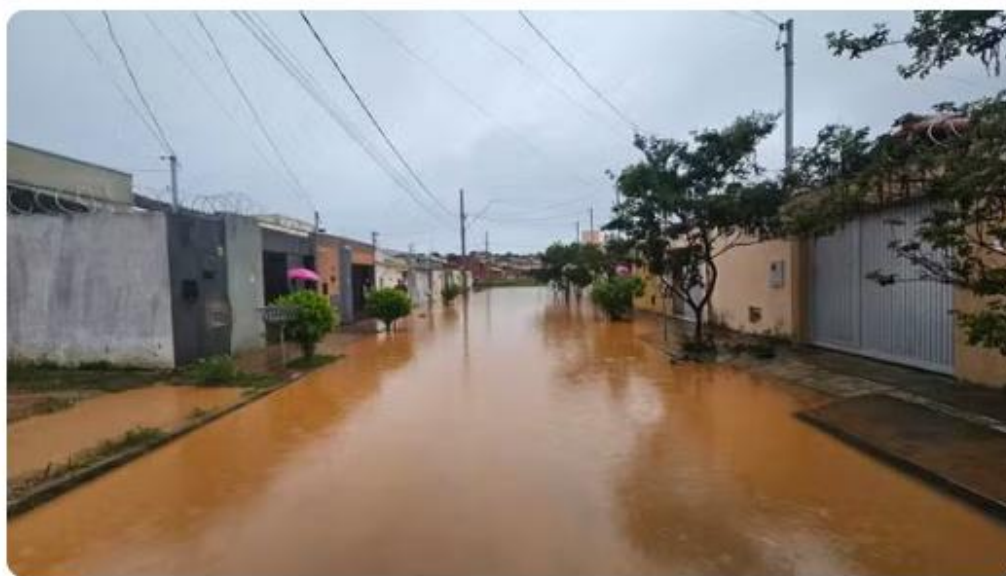
Imagem de rua no bairro Delfino — Foto: Corpo de Bombeiros
