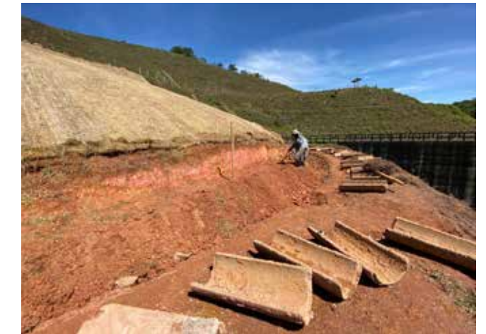
Remoção das canaletas "meia cana" de drenagem para nivelamento e reassentamento
