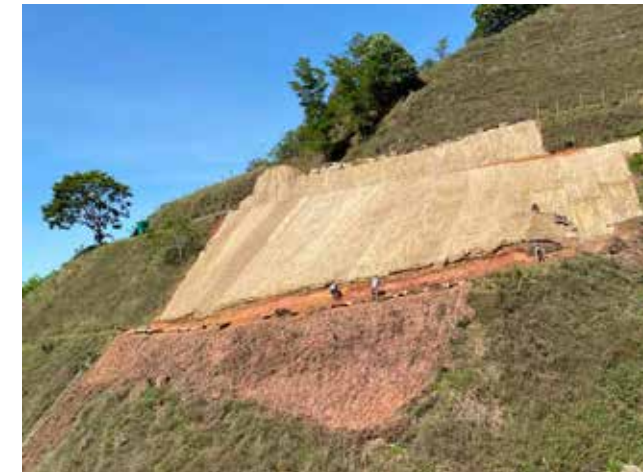
Situação do talude após semeadura e colocação da geomanta
