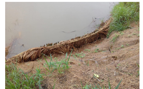
Paliçada e biomanta sendo instaladas (novembro de 2020)
