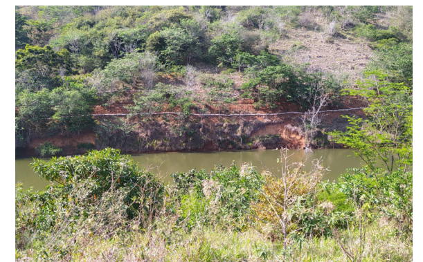
Retentores orgânicos instalados acima do foco erosivo (outubro de 2020)
