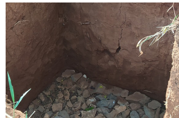
Estrutura para sistema de drenagem de água superficial construído acima do foco erosivo (outubro de 2020)
