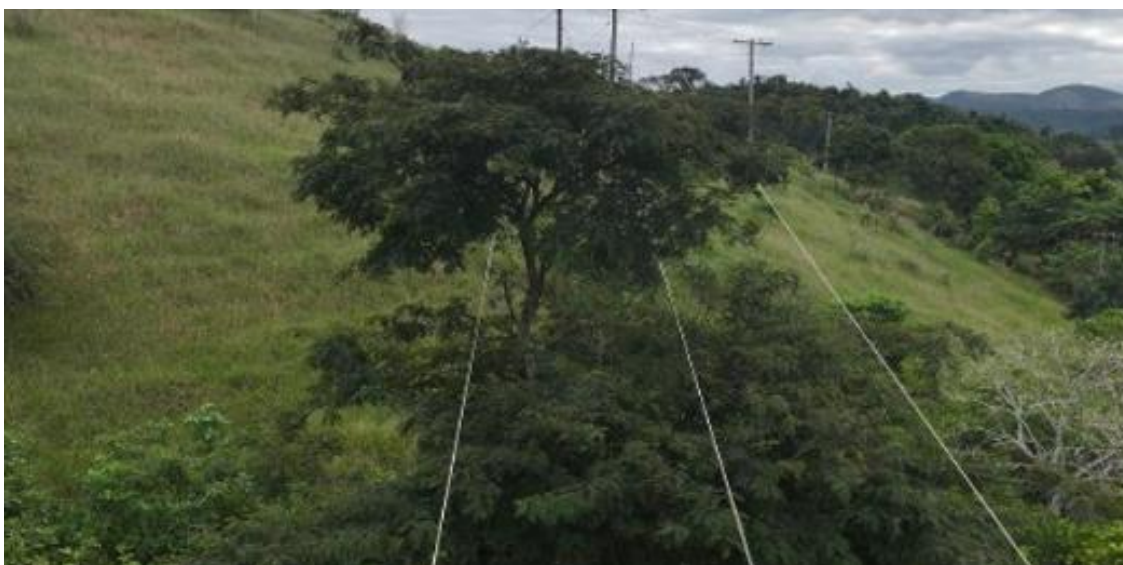
Imagem 1: Árvores sob a rede elétrica.
