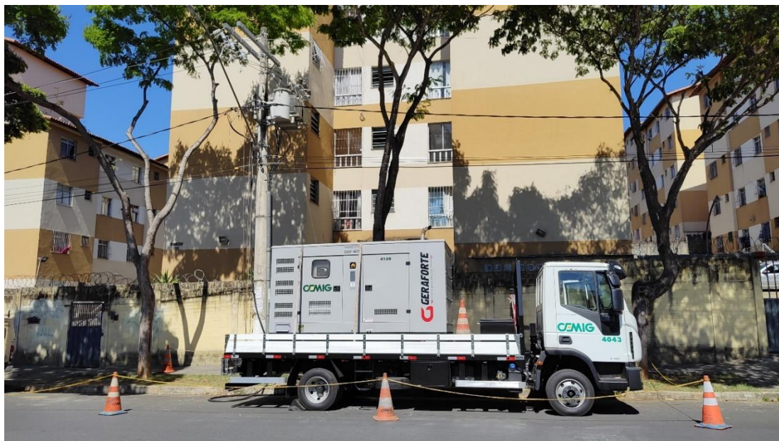
Foto 03: Instalação de Gerador
