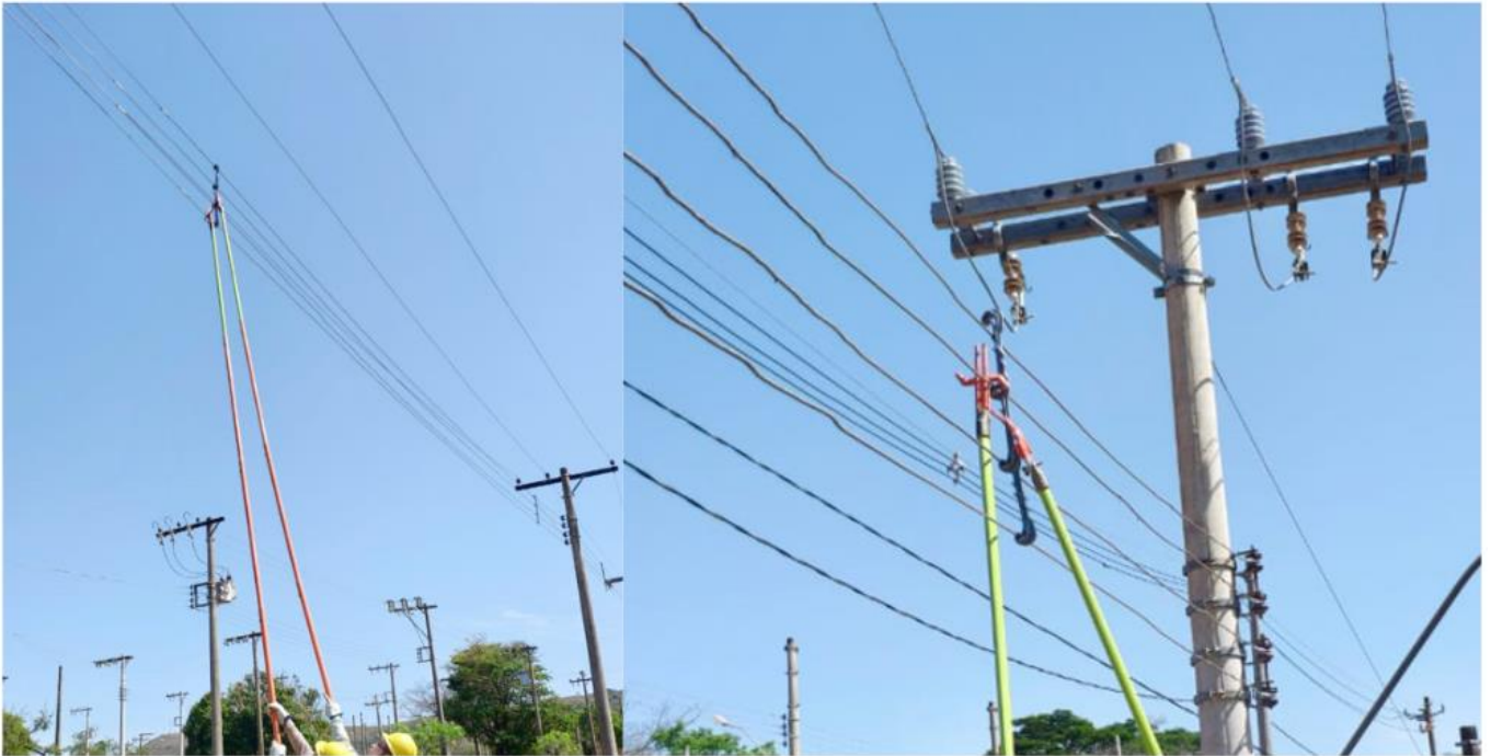
Figura 2: Instalação de espaçadores em rede BT na UniverCemig.
