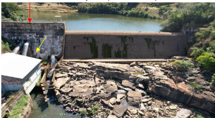
Foto 05 Vista aérea da tomada d'água (seta vermelha) e dos condutos forçados (seta amarela)
