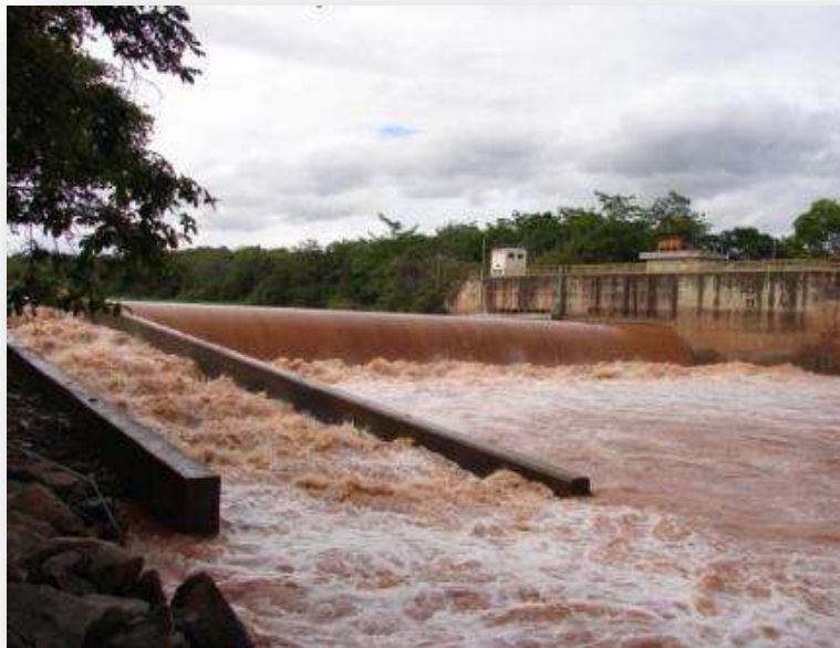
Figura 21. Sistema de transposição do tipo escada da Usina Térmica de Igarapé
