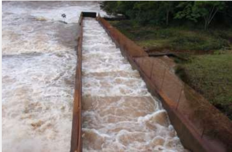
Figura 20. Sistema de transposição do tipo escada da Usina Hidrelétrica de Salto Moraes
