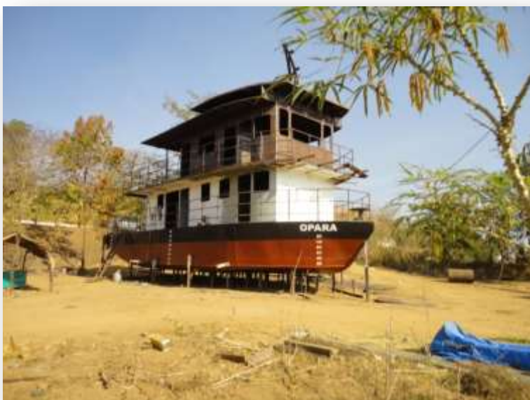
Figura 94. Construção do barco pesquisa
