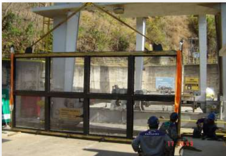
Figura 75. Inserção das grades anti-cardume na UHE Três Marias
