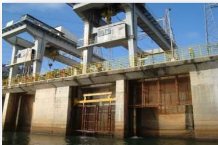
Figura 74. Grades anti-cardume na UHE Três Marias
