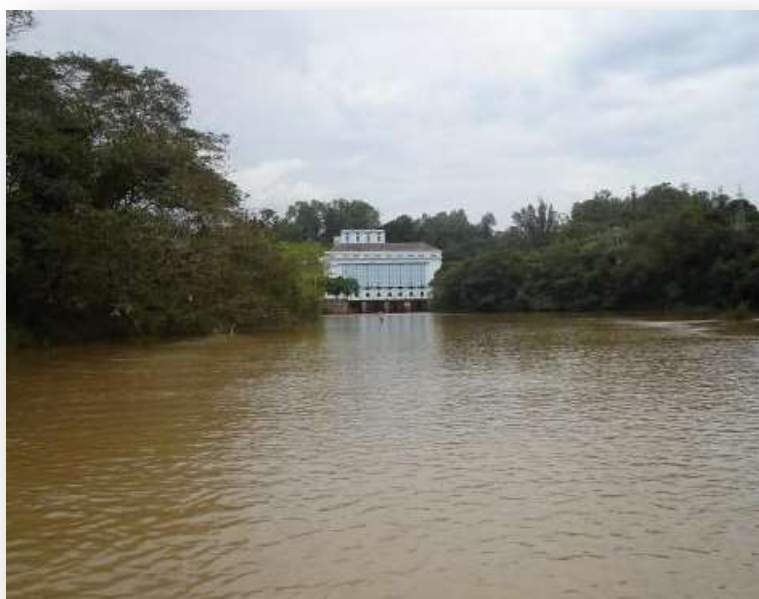
Figura 56. Usina de Gafanhoto
