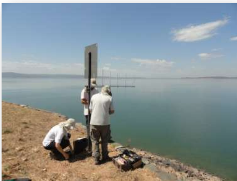
Figura 60. Instalação das antenas receptoras
