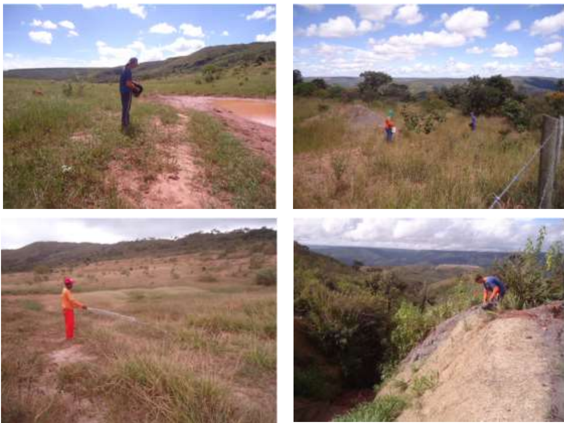
Figura 33. Atividades de manutenção no PRAD da UHE Irapé
