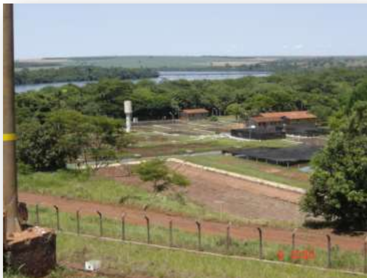
Figura 7. Estação de Piscicultura de Volta Grande
