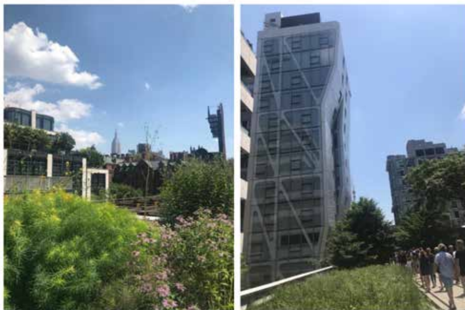
Figura 5 - Vista do Parque High Line - Nova York. Fonte: Biondi (2019).
