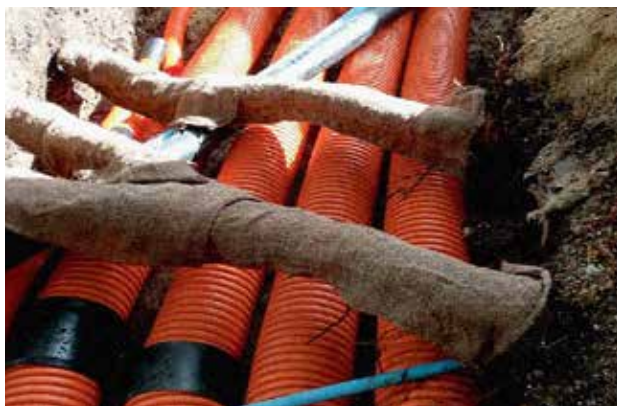
Figura 14 - Detalhe de raízes envoltas com material protetor contra a radiação solar e a dessecação até que o solo seja repostado na vala. Fonte: Barrall (2017).
