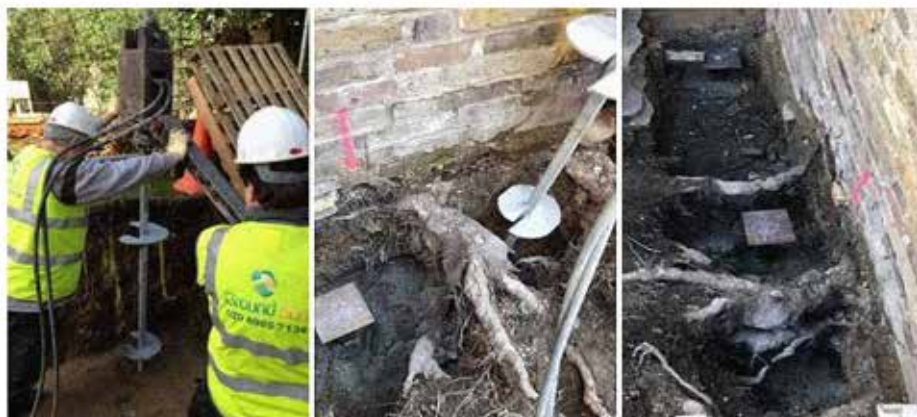
Figura 18 - Lances do processo de confecção de fundação estrutural pelo método do empilhamento de estacas parafusadas. Fonte: www.groundsun.co.uk .
