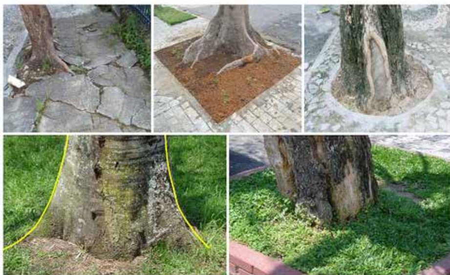
Figura 12 - Relação da base do fuste das árvores com as características das calçadas que a abrigam. Acima, à esquerda, danos ao piso provocado pelas raízes superficiais, típicas da espécie; acima, ao centro, adequação do piso às características da espécie; acima, à direita, corte das raízes como tentativa de eliminação do conflito. Abaixo, situação normal da base do fuste, à esquerda, e colo enterrado, à direita.
