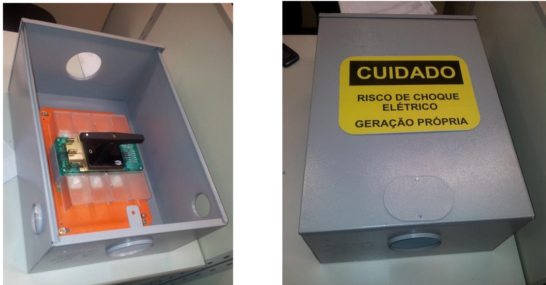
Figura 6 – Exemplo de disposição do DSV (CM7-DSV – 250 A)
