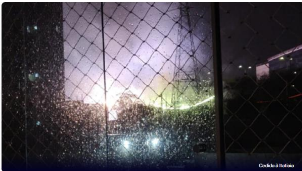
Explosão provocada por raio assustou moradores de prédio de BH
