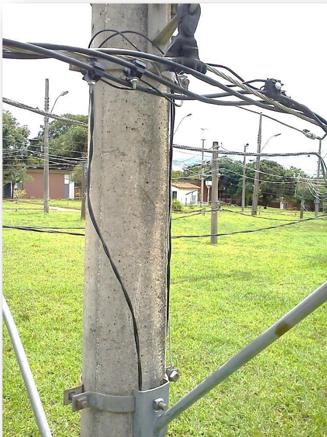
Foto 1 – Montagem do novo padrão de aterramento e ligação da iluminação pública. O cabo deve ser trançado e sair por cima do braço de IP.
