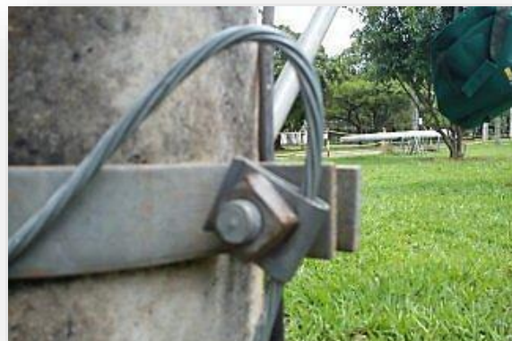
Foto 2 – Detalhe da ligação dos cabos de 1,5 mm 2 através dos conectores de perfuração.
