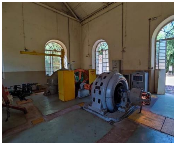
Figura 11 Unidade geradora
