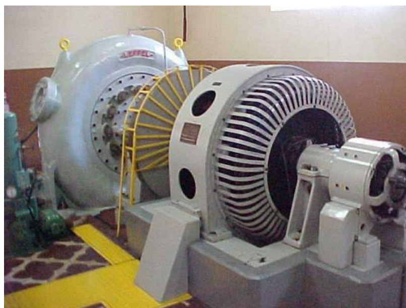
Figura 23 Unidade geradora
