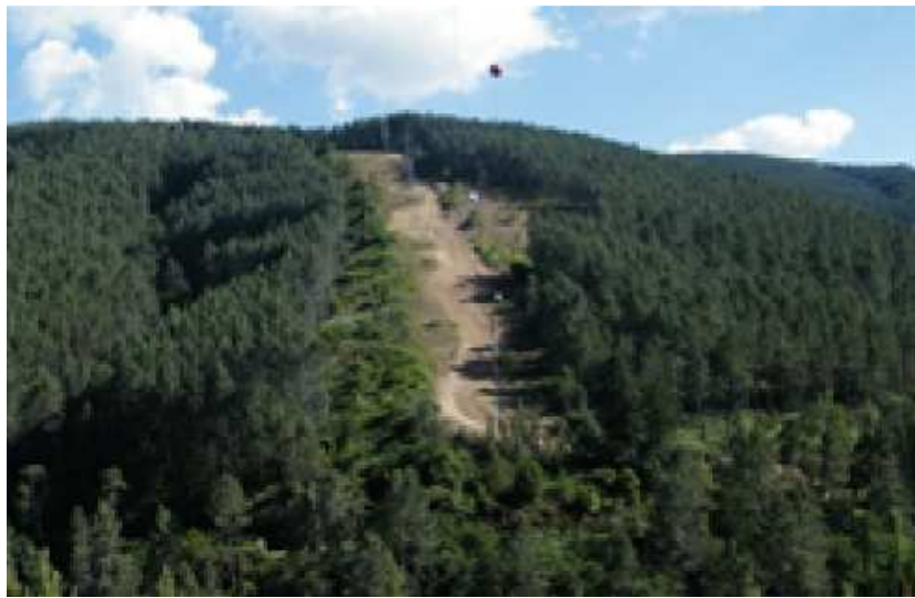
Figura 43 - Faixa de gestão de combustível da rede elétrica de muito alta tensão.
