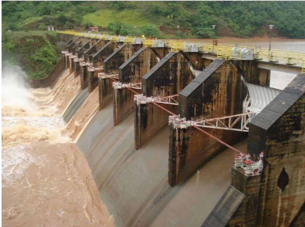
Figura 2 – Barragem Santo Antônio
