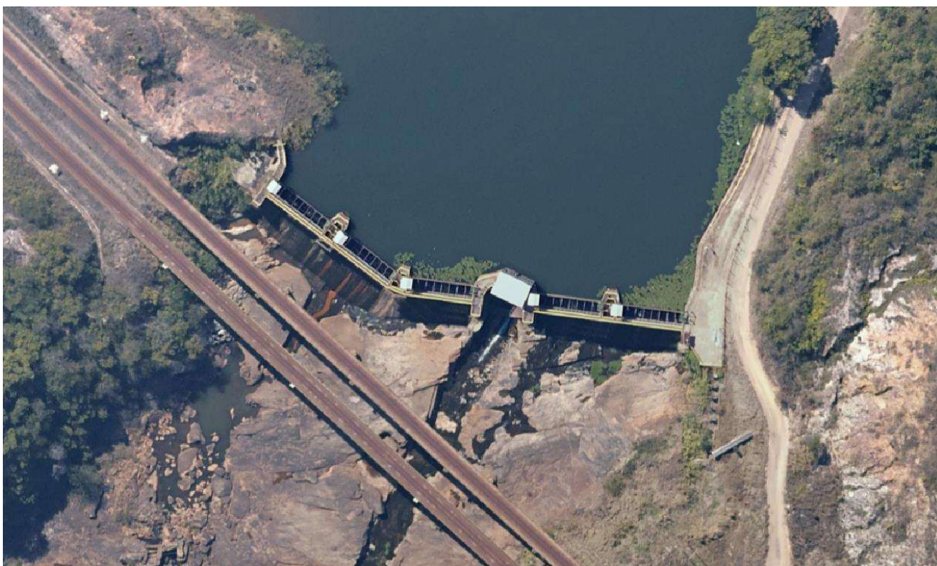
Figura 1 - Vista superior da barragem Antônio Dias
