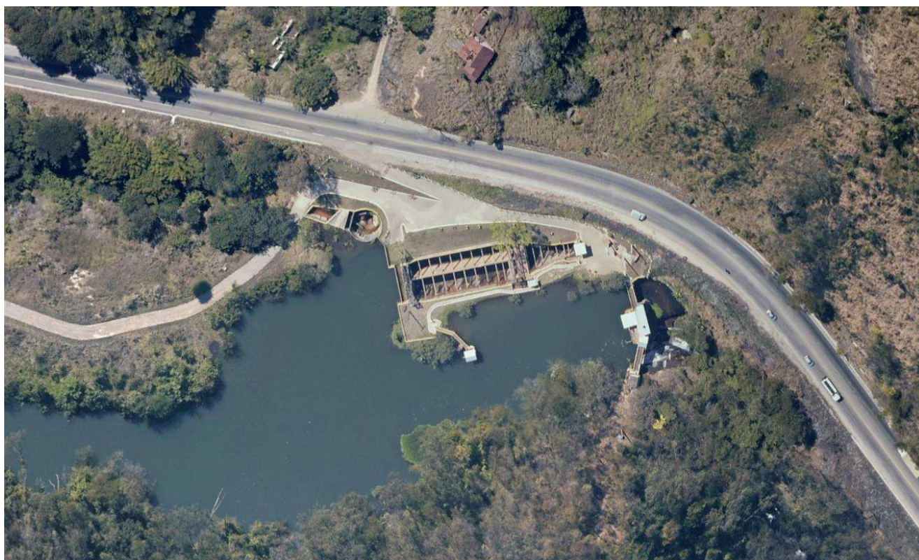
Figura 2 – Vista superior da barragem Severo
