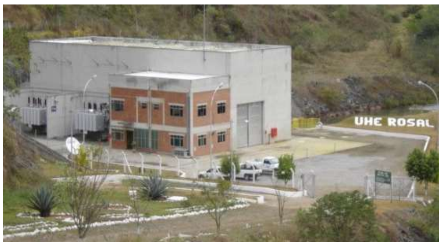
Figura 2 - Casa de força
