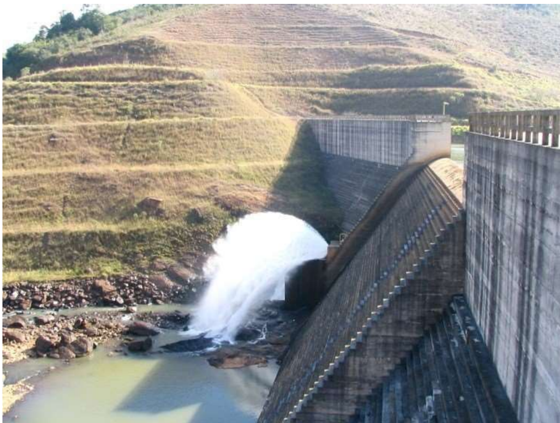
Figura 1 - Vista lateral a jusante da barragem
