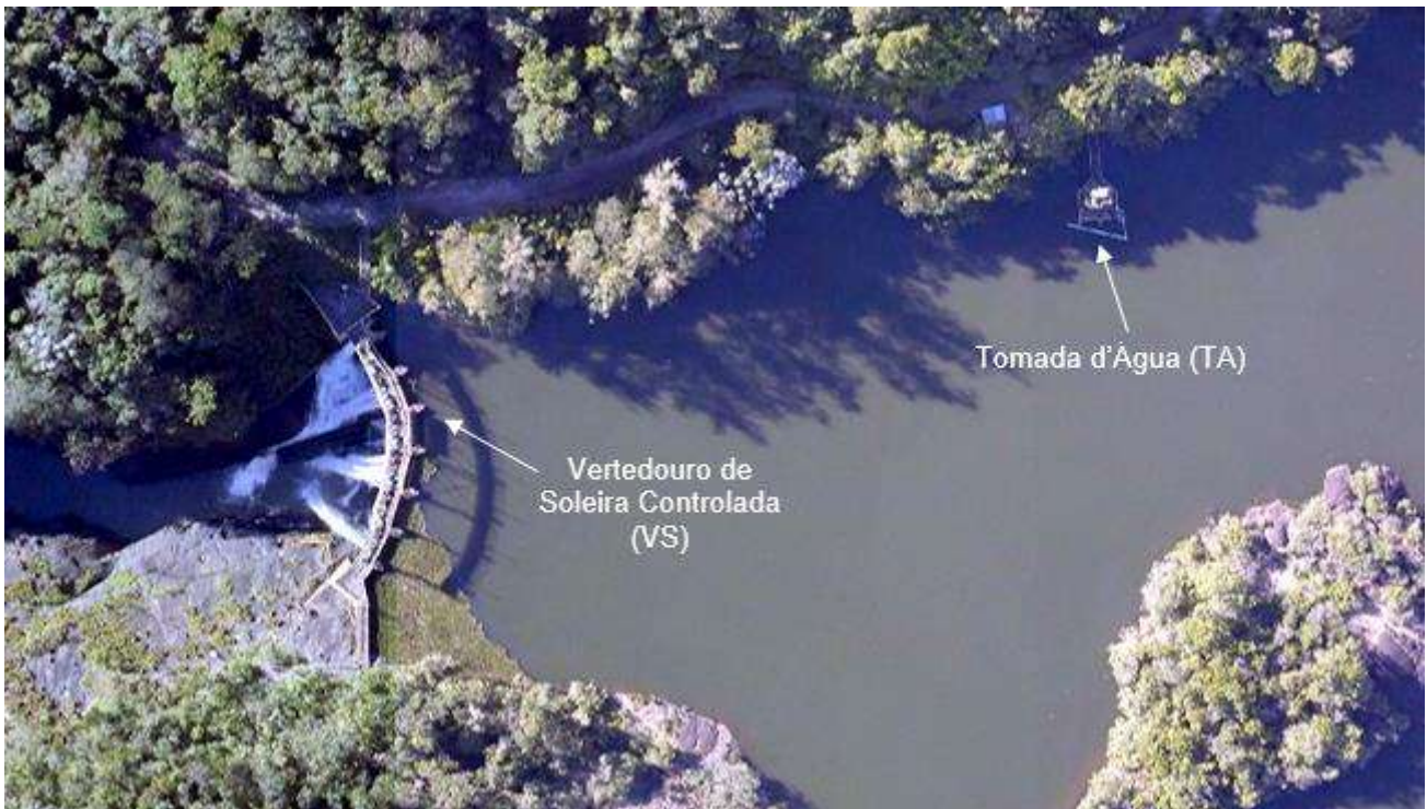
Figura 2 - Vista aérea com estruturas da usina
