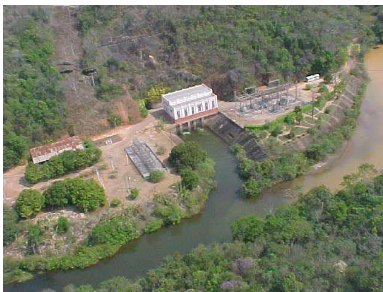
Figura 3 - Casa de força
