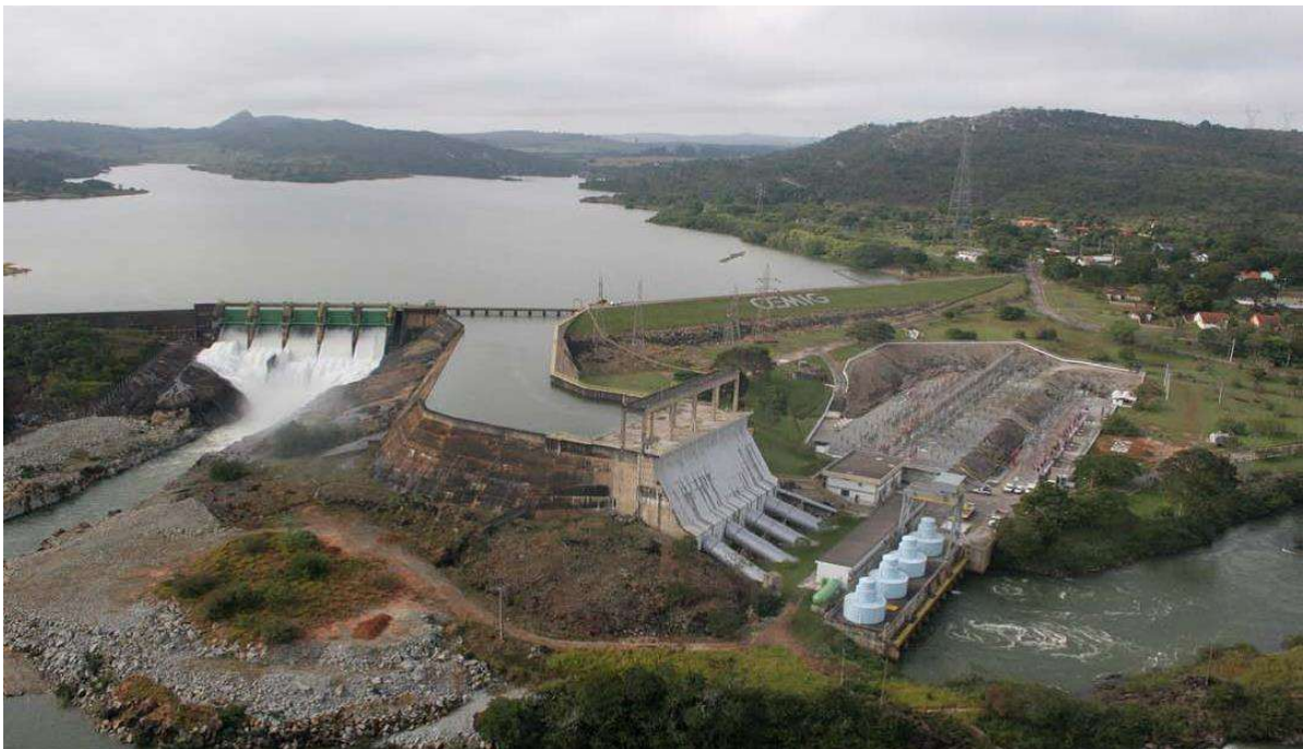
Figura 1 – Barragem da UHE Itutinga
