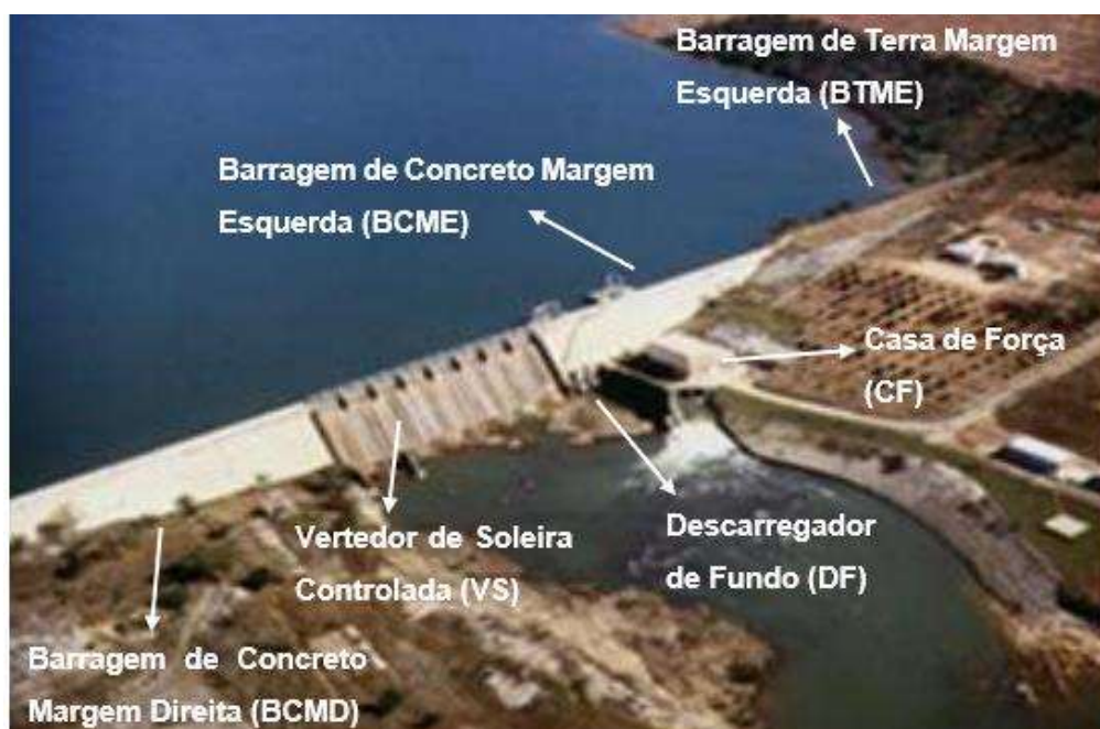
Figura 1 - Estruturas do Empreendimento da UHE Cajuru
