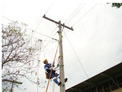
Poste da rede tronco
