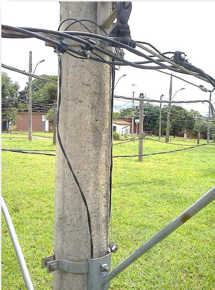
Foto 1 – Montagem do novo padrão de aterramento e ligação da iluminação pública.
