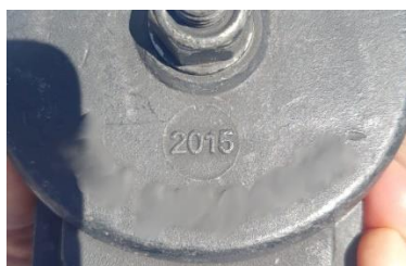
Figura 2- Indicação da data de fabricação gravada no corpo da carretilha dupla ação
