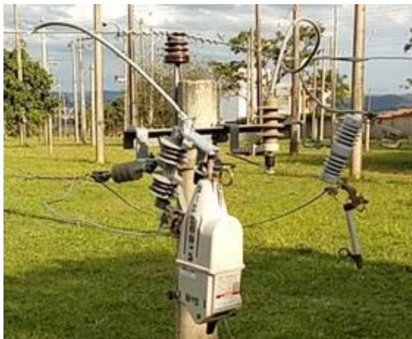
Figura 1 -Estrutura U1-U3 pst de 11m existente
