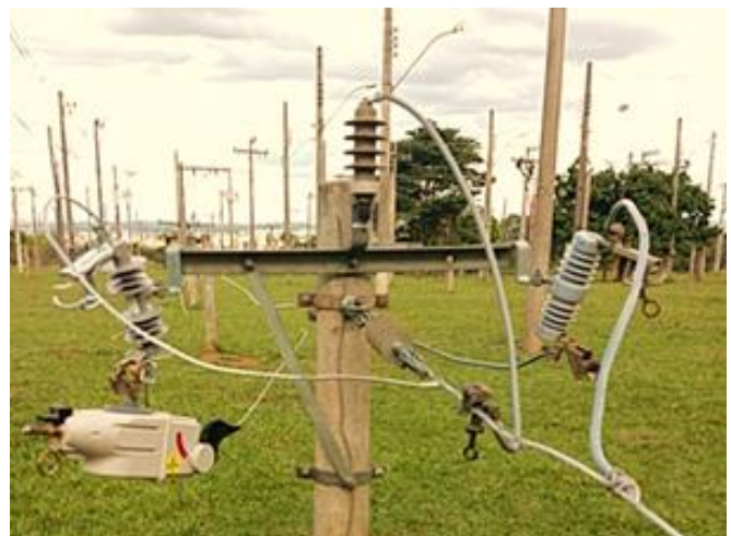
Figura 2 - Estrutura U4 em poste de 11m existente
