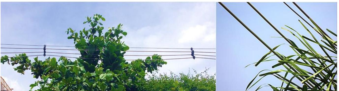
*Figura 3 - Instalação do cabo coberto dupla camada em projeto piloto*
