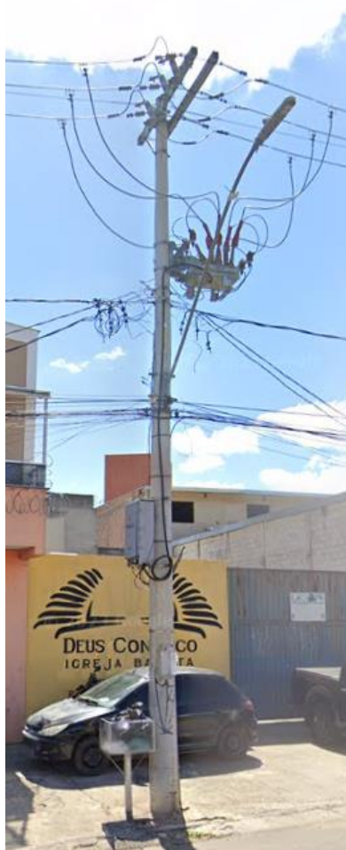
Figura 2: Estrutura do Religador Urbano de 15 e 24,2 kV com transformador de 10 kVA;
