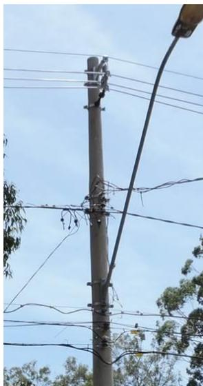
Figura 1: Poste de PRFV seção circular (foto ilustrativa)
