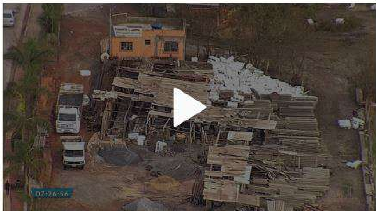
Bairros de Ribeirão das Neves, na Grande BH, ficaram sem energia após temporal
