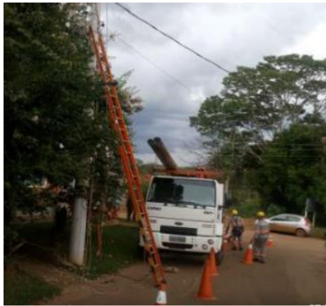
Imagens 1, 2 e 3 - Equipes trabalhando no restabelecimento de energia
