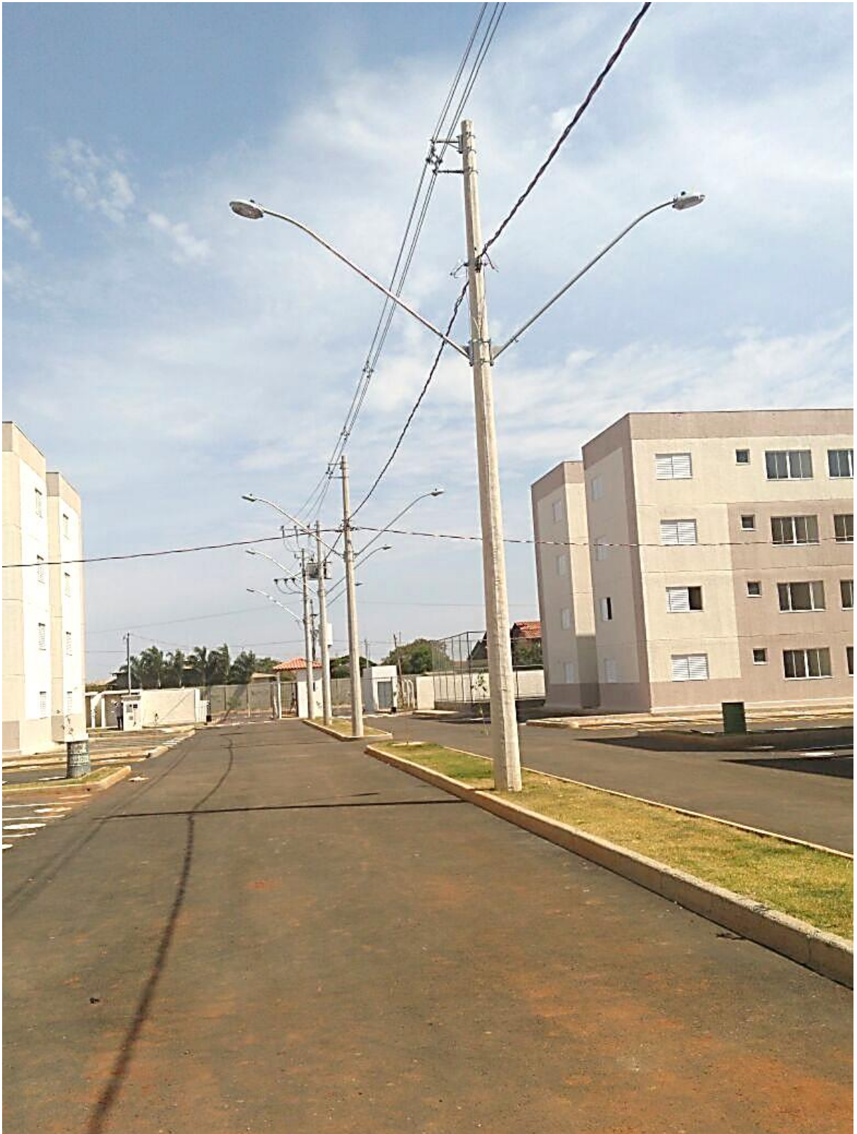
Foto 3 - Alocação de postes em canteiro central
