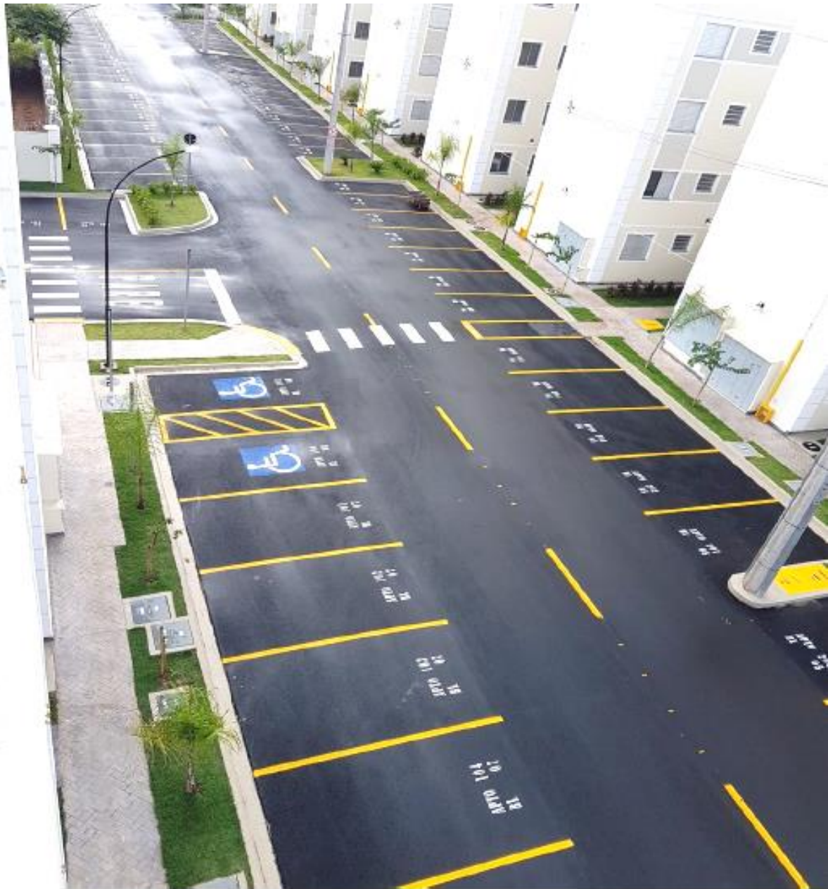
Foto 2 - Alocação de postes alinhados com as vagas
